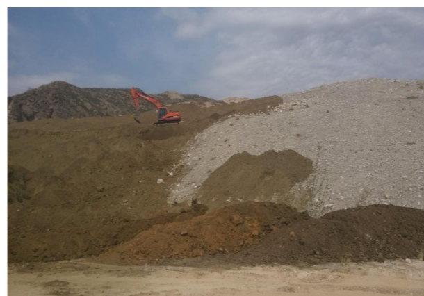
杨家甸矿区整改前
